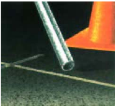
2. Limpiar la roza. Usar aire a presión para eliminar polvo y partículas de la roza
